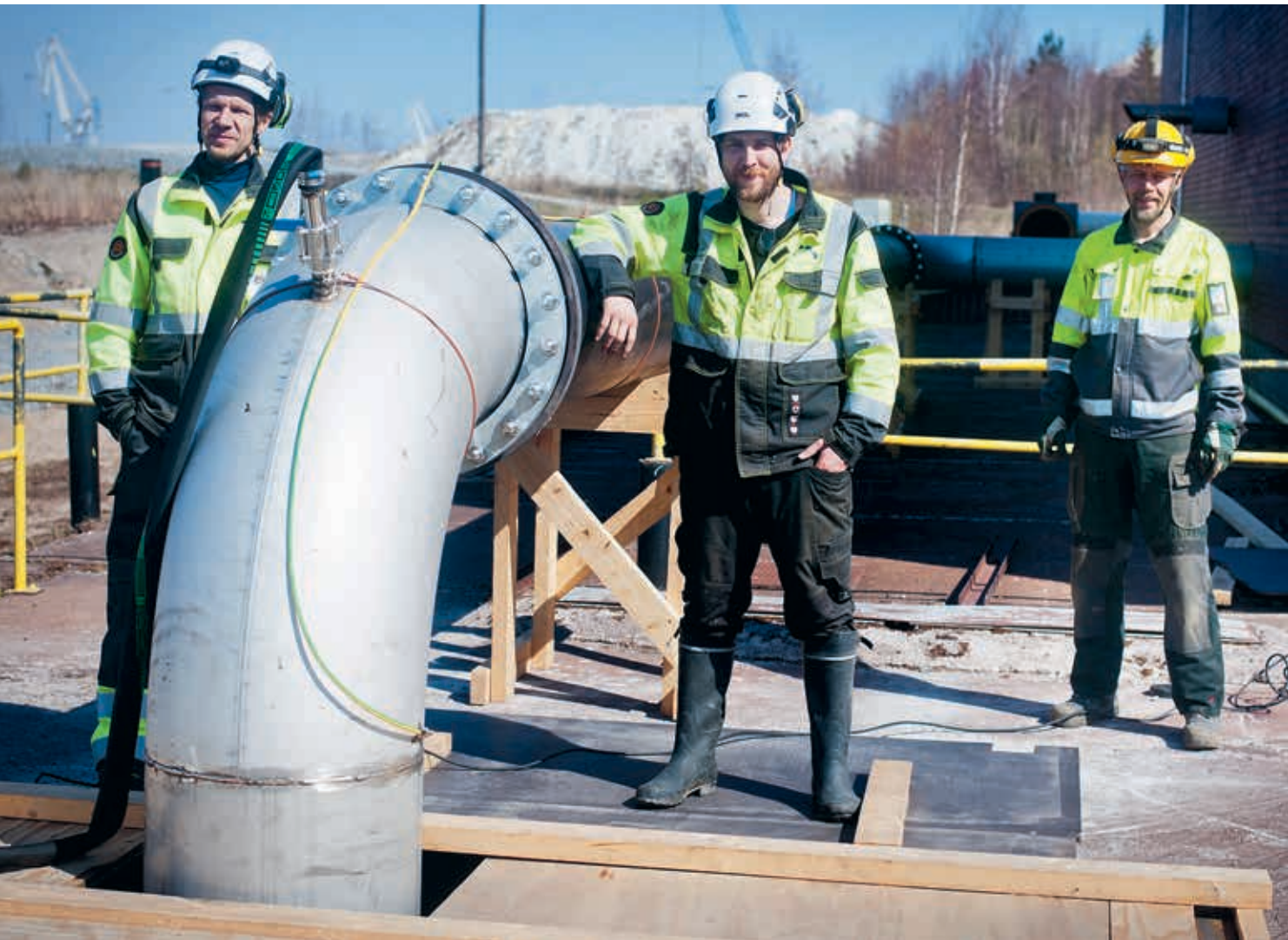
Asennusurakan ajan koriketjusuotimen kammion ohitus tapahtui väliaikaisella pumppauksella. Ohitusputken äärellä Multimekanon toimitusjohtaja Jukka Pirttiniemi (vas.), asentaja Dan Wood ja työnjohtaja Vesa Heikkilä. KUVAT JORMA UUSITALO
