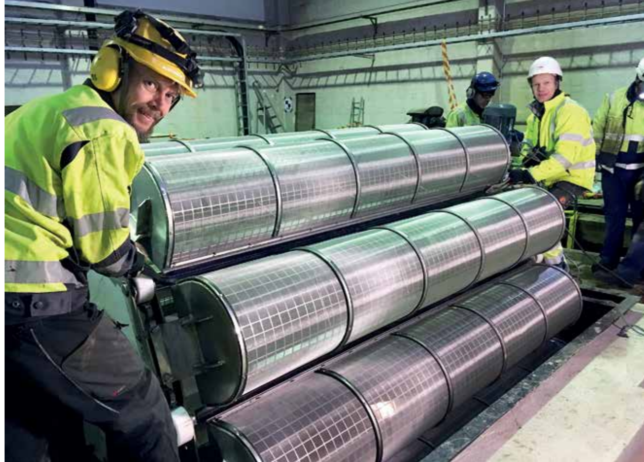
Vesa Heikkilä (vas.) ja Jukka Pirttiniemi Suomen Multimekano Oy:stä ovat tehneet merivesipumppaamolla uuden ketjukorisuotimen asennustöitä. KUVA JORMA PALOMAA
